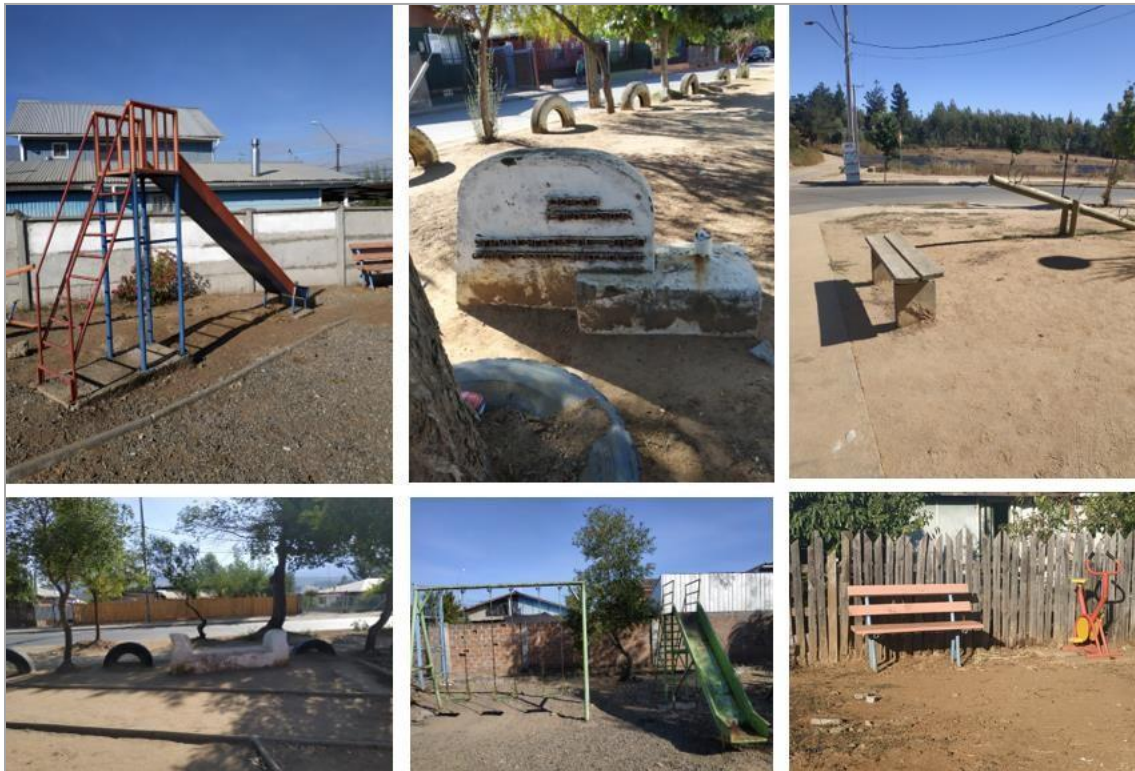
Imagen 22: Fotografías áreas verdes sin mantención zona urbana Quirihue
